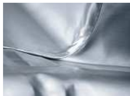
Firstseitige Kaminecke in Falztechnik mit RHEINZINK®-Anformzink „glatt“
