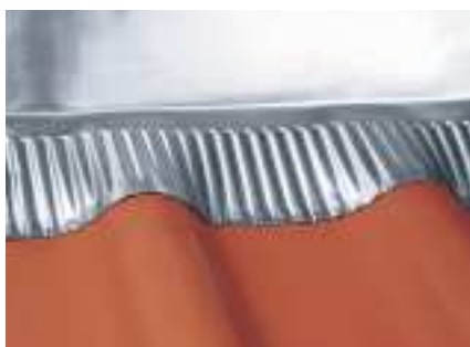
Taufseitiger Kaminanschluss mit RHEINZINK®-Anformzink „plissiert“
