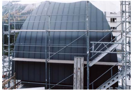
RHEINZINK-Titanzinkdeckung mit 3 m langen Blechen und Winkelfalzen.
