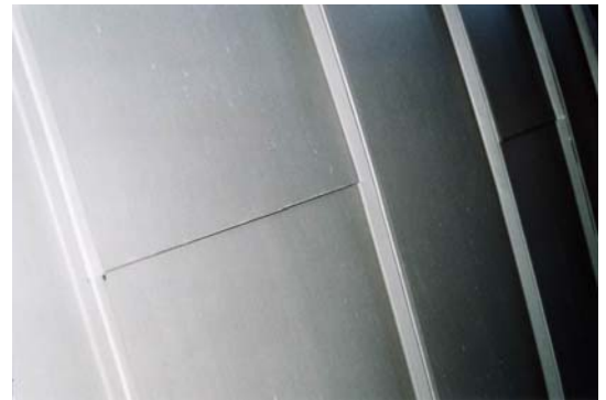
RHEINZINK-Titanzinkdeckung mit 3 m langen Blechen und Winkelfalzen.
