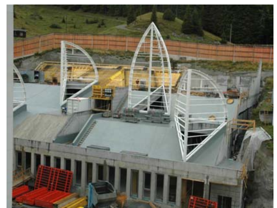
Im Rohbau gut zu erkennen sind die dreieckförmigen Dachöffnungen und die klassische Botta-Front.
