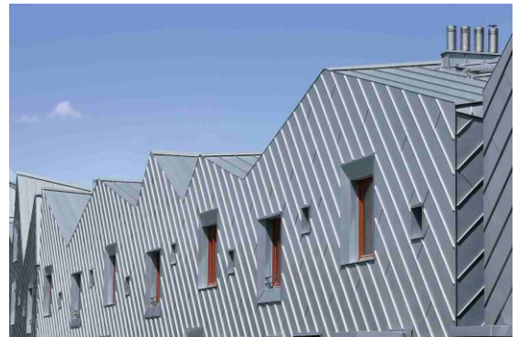
Die MikMaks – eine moderne Interpretation britischer Reihenhäuser. Titanzink von RHEINZINK verbindet die sehr unterschiedlich geformten Häuser zu einer Einheit. (2296-051_A5_RET)
