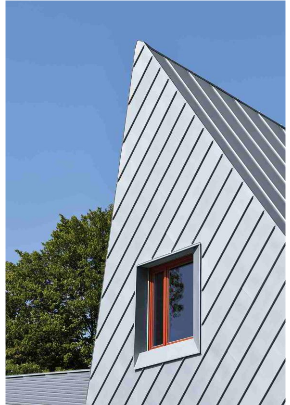
Die Verarbeiter erstellten zuerst den Anschlussrahmen um die Fenster und hängten anschließend die Schare in diesen Rahmen ein. (2296-024_A5_RET)
