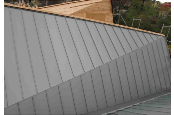
Eigene Traufabschlüsse schützen die darunterliegende Fläche zuverlässig vor eindringender Feuchtigkeit. (IMG_1944)
