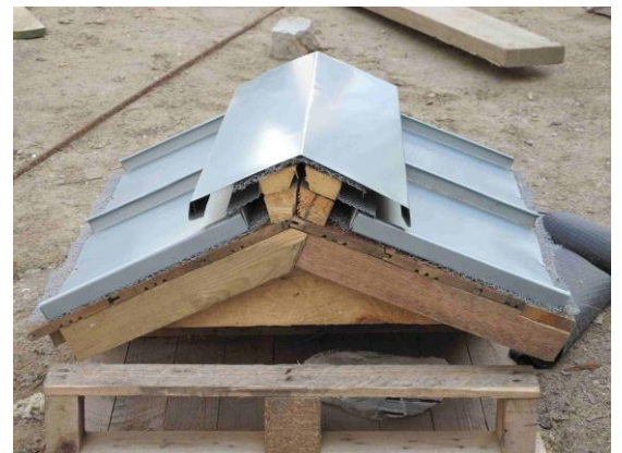
Die Lüfterfirste wurden in flacher Ausführung für steiler geneigte Dächer ausgeführt, hier ein Konstruktionsmodell. (IMG_1957)
