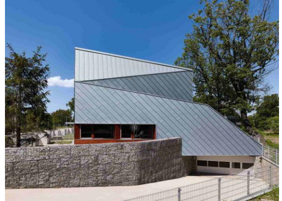
Holzfenster, Holztüren und Holzverkleidungen unterstreichen die elegante Fassaden- und Dachbekleidung, hier die Einfahrt zur Tiefgarage. (2296-009_A5_RET)
