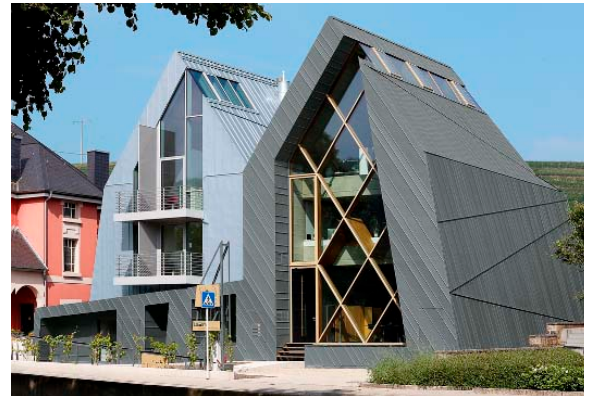
((Datei 2367-006_Foto RHEINZINK)) Die Titanzinkbekleidung fasst das aus einer Wohnung (links) und dem Architekturbüro (rechts) bestehende Doppelhaus zu einer Einheit zusammen, zeigt aber durch die unterschiedlichen Oberflächen und Falzanordnungen zugleich die unterschiedlichen Funktionen.
