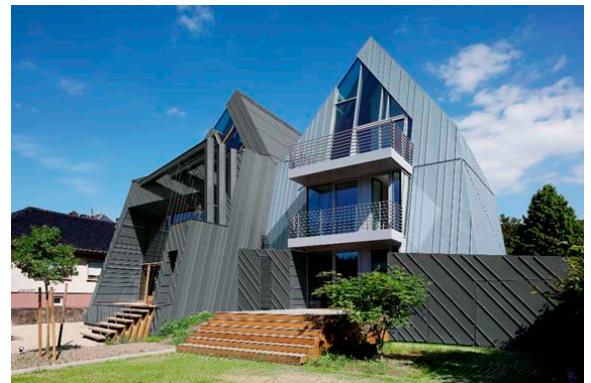
((Datei: 2367-034_Foto RHEINZINK)) Die Rückseite ist von vielen Detail- und Anschlusssituationen geprägt, für die es kaum Standardlösungen gab: Links etwa die dreifache Trägerkonstruktion, in der Mitte der Haustechnikraum mit Entlüftungsgitter und ganz rechts eines der bekleideten Garagentore.
