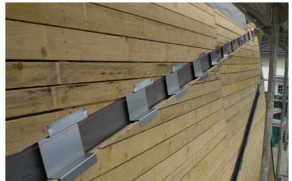
((Datei: 2_Residence_Grevenmacher_8)) Montage der Traglaschen für die Rinnenkonstruktion
