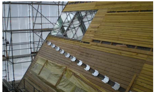
((Datei: Residence_Grevenmacher_3)) Traglaschen für die Fassadenrinne und Einbindung der Fensterelemente in die Fassadenkonstruktion
