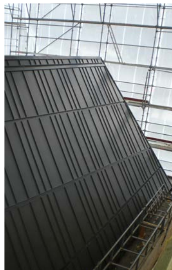
((Datei: Residence_Grevenmacher_8)) Fertiggestellte Dach-/Fassadenfläche unter dem Kederdach
