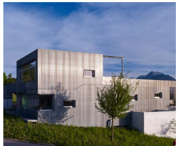
((Datei: Datei: 2311-078)) Auf der Nordseite ist das Sullnerhaus nur dort geöffnet, wo es aus funktionaler Sicht sinnvoll ist. Foto: Rheinzink
