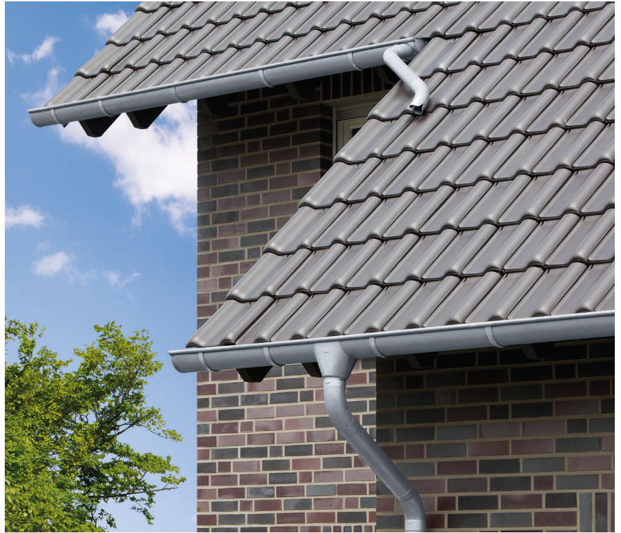
Drehhaltersystem Rinnenschiene mit Steckverbindung und Rinnendrehhalter gemäß DIN EN 1462
