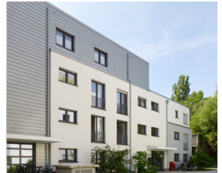
Wohnanlage, Köln, Deutschland
