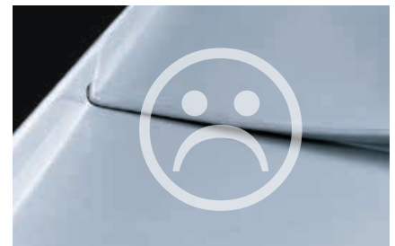
Pultdachfirst ohne Bewegungsbereich und zu geringer Aufstellhöhe
