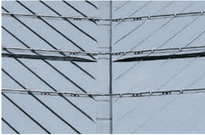
Kehlrinne vertieft auf Strukturmatte
