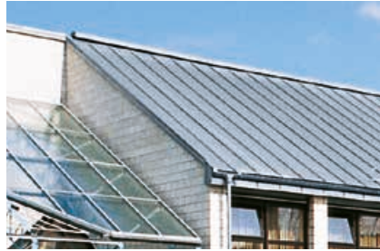
Pultdachfirst mit Holzleiste
