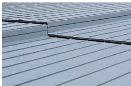
Quernaht als Gefällestufe
