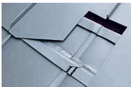
Detailoptimierung: Zusatzfalz
