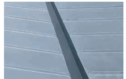
Innenliegende Kastenrinne mit ausgeklebter Sicherheitsrinne
