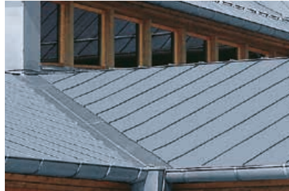
Kehle mit Einfach- und Zusatzfalz
