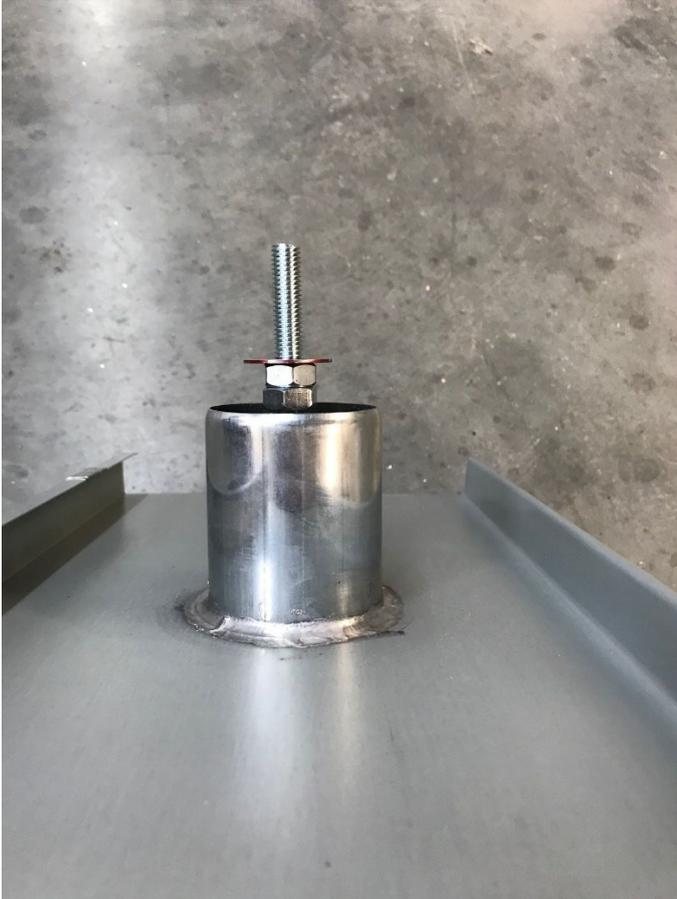
Unterteil Stockschraubeneinfassung (DN 60) mit Dachdeckung verlötet
