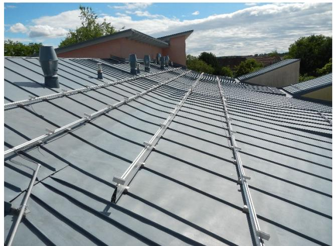
Durchgehende Schienensysteme führen zu Überbeanspruchung in Querrichtung
