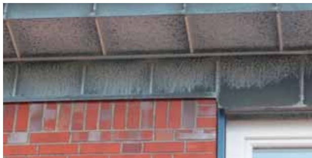
Beispiele für Salzablagerungen an Dachuntersichten und Unterseiten von Dachrinnen
