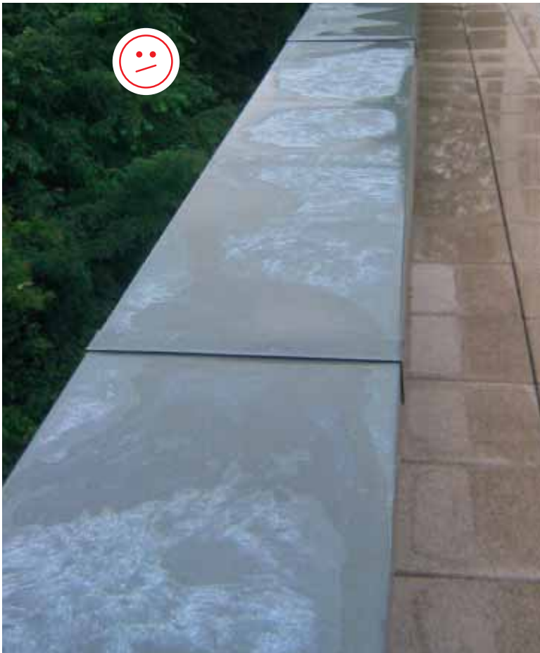
Bildung von Zinkhydroxid durch unzureichendes Gefälle
