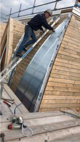
Bis zu fünf Facharbeiter fügten rund ein Jahr lang die maßangefertigten Titanzink-Paneele zu einer präzisen handwerklichen Einheit zusammen. Foto: Ridder Skins for Buildings
