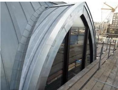
Die Fenster- und Dachanschlüsse wurden in feinen Details angepasst und exakt ausgeführt.
