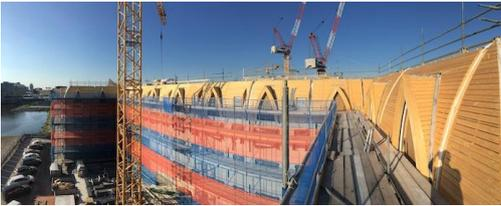
Die vorgefertigte Brettholzschalung dient als Unterkonstruktion für die nicht selbsttragenden Titanzink-Paneele. Foto: Ridder Skins for Buildings
