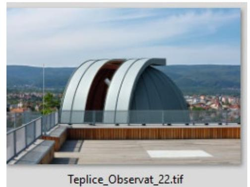
Konische Titanzinkschare für die Kuppeln und der elegante Schwung der Öffnungsflügel sorgen für eine funktionale, dabei aber auch optisch spannende Architektur. Eine besondere Herausforderung war der (schlag-)regendichte Anschluss der beweglichen Flügel an die drehbare Kuppel. Foto: Rhein-zink
