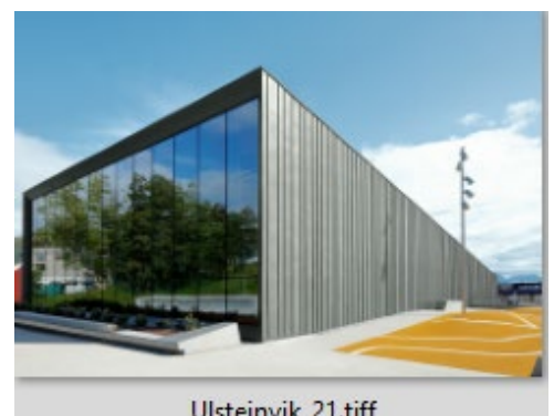
Die gesamte Anlage ist barrierefrei geplant und konzipiert. Foto: RheinZink
