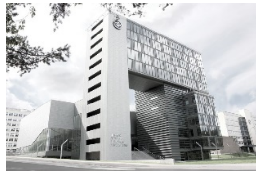
((Dateiname: 1_Ansicht Nord-Osten)) Das Tor symbolisiert die Offenheit der Universität und markiert den Eingang zum Gebäude und Gelände. Foto: A.S.A. Sigito Kuncevičiaus / Žygmantas Gudelis
